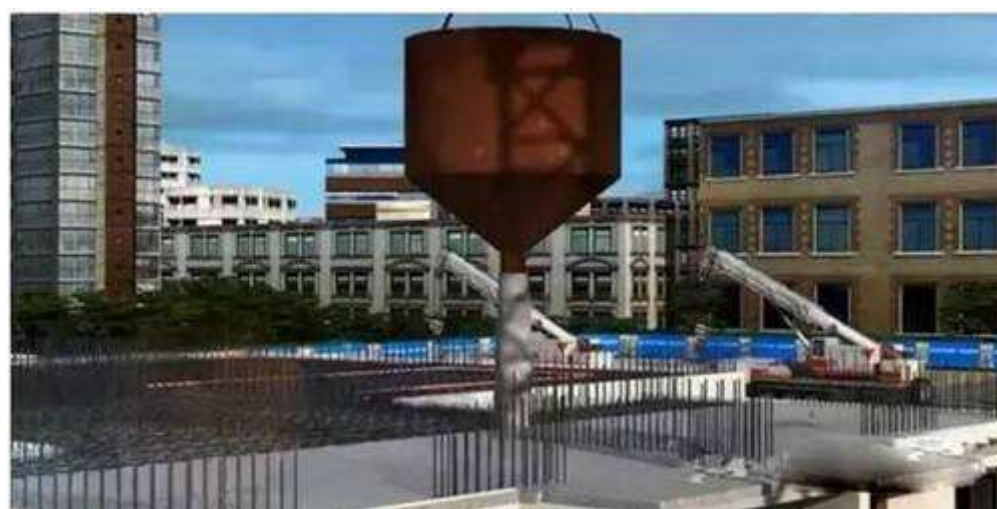
14、楼板混凝土浇筑。
