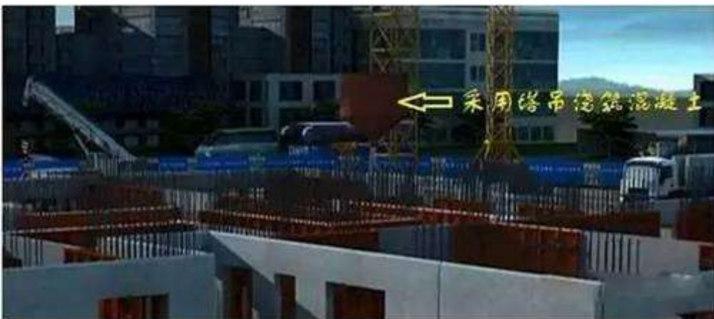
8、墙、柱浇筑混凝土。
