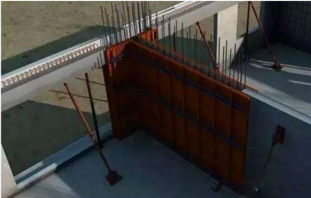
8、墙、柱浇筑混凝土。
