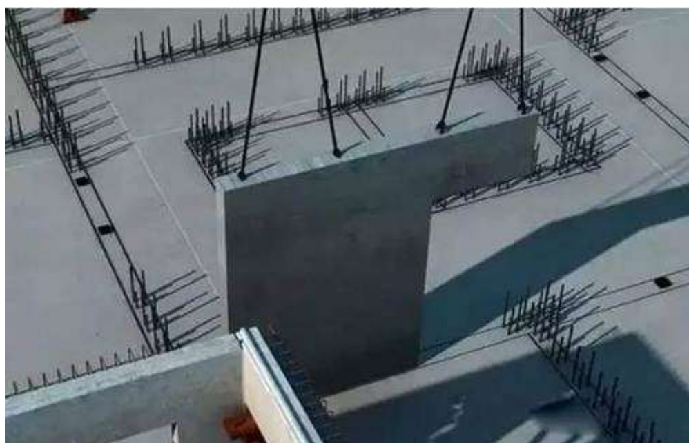
5、柱、剪力墙钢筋绑扎。
